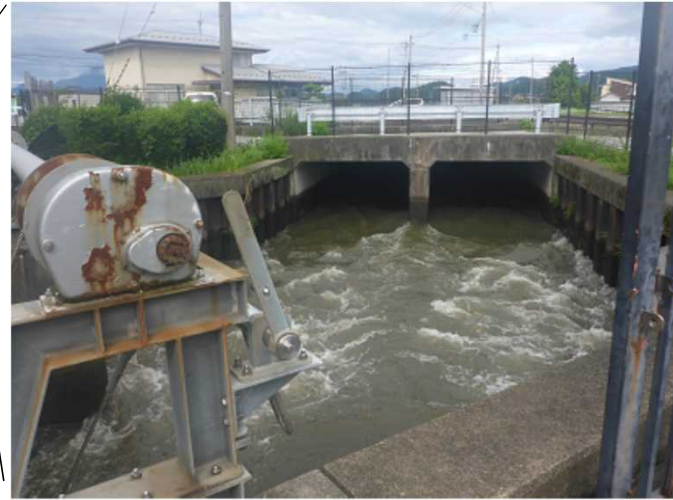
内水排除操作中の排水機場呑口の状況 (米原排水機場)
